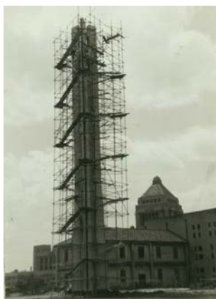
写真「建設中の時計塔」 1960（昭和35）年頃撮影
