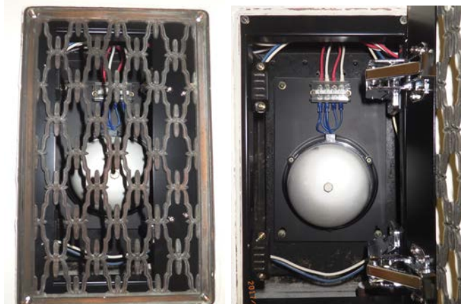
現在の開会報知電鈴 (通常時外観と扉を開けたところ)
