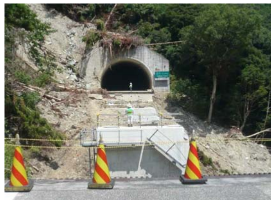
立川橋崩落現場（大豊町）
