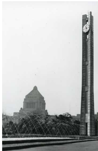
建設当時の時計塔
