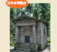
日本水守館 (1891年(明治24)設置) 全国の土地の標高を決める基準点です。
