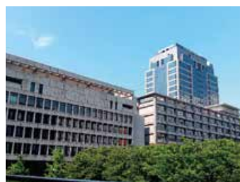
▲ 千葉県庁 議会棟(左) 中庁舎(右手前) 本庁舎(右奥)
