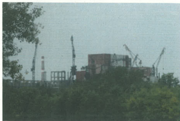
【写真】 建設中止となった第5号炉
