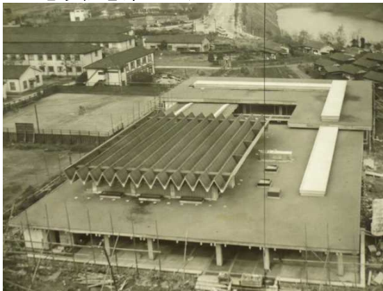
完成間近の尾崎記念会館。左奥の建物は参議院議員会館（1959 年（昭和 34）頃）。
