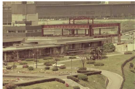
【建設中の新館風景】
