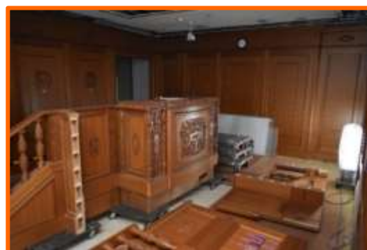
〔議場体験コーナーの移転工事の様子〕
