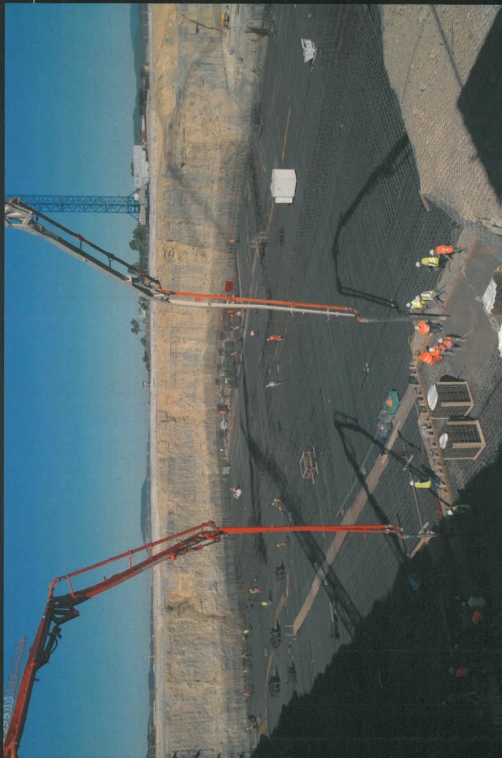
耐震ピット設置作業を開始、初日、800 m<sup>3</sup>のコンクリートを注入。この作業を向こう3ヶ月の間、21回繰り返し、トカマク施設の基礎工事が完成する予定。(F4E写真提供)
