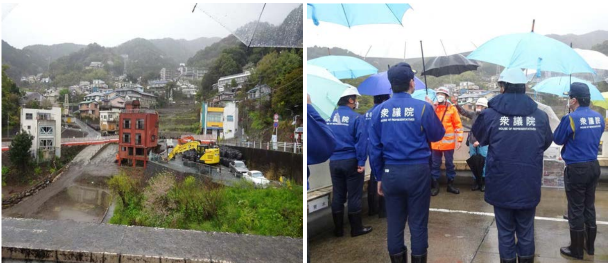
逢初川中流部般若院付近（静岡県熱海市）
