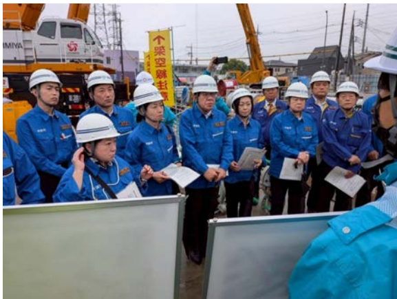
八潮市道路陥没現場（埼玉県八潮市）
