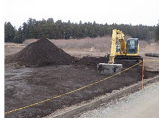
特定復興再生拠点区域での農地除染工事の様子 (福島県富岡町)
