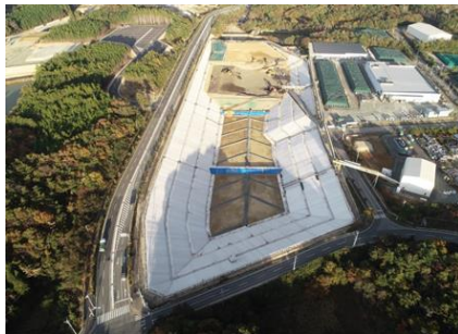
土壌貯蔵施設の様子
