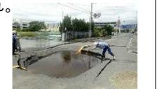
大阪北部地震での水道管破損による道路陥没(大阪府高槻市:平成30年)
