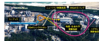
写真：J-PARC全景
