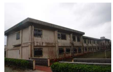
老朽化した刑事施設の外観の様子
