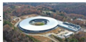
写真：次世代放射光施設 (整備中)全景
