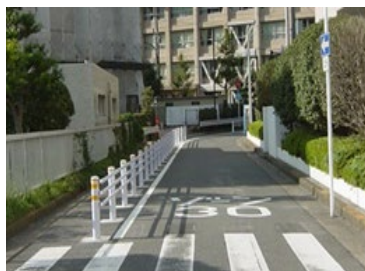
(防護柵の整備)
