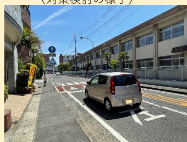
(スムーズ横断歩道設置状況)
