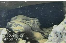
格納容器底部の堆積物
