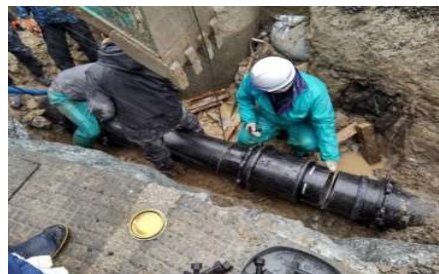
令和6年能登半島地震における 水道管復旧工事
