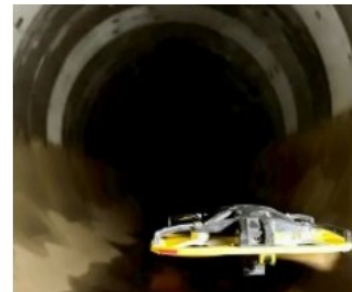
技術の高度化・実用化の例：ドローンによる目視点検
