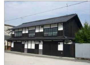
【広島県庄原市】 三軒続きの長屋住宅を 交流・展示・観光施設として活用
