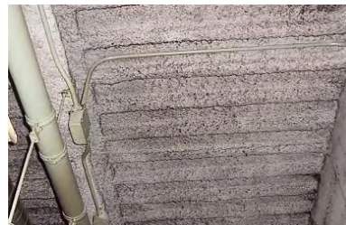
吹付けロックウール
