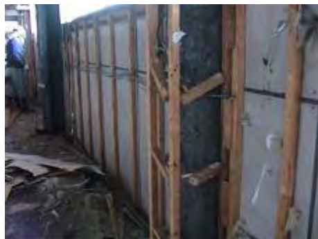
アスベストが使用されている特定建設資材の例
