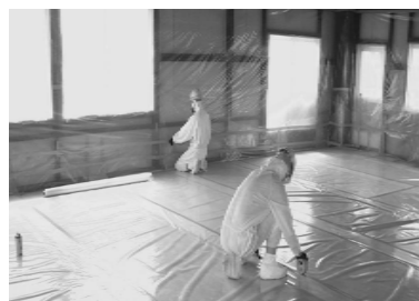
養生作業（作業場所の隔離）
