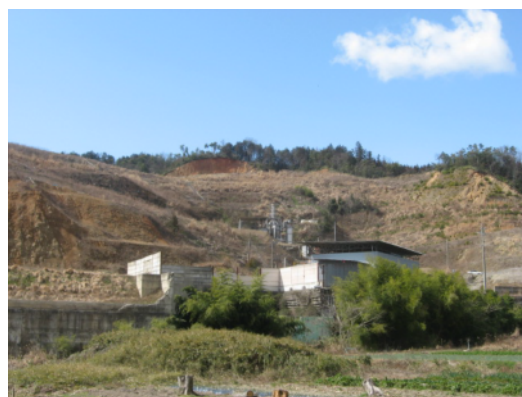
岐阜市椿洞の不法投棄現場。中腹には産廃の選別施設と焼却炉がみえる。
